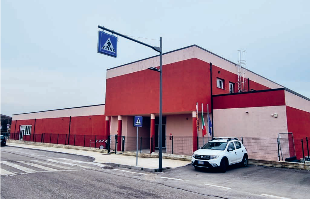
La nuova struttura della scuola primaria di San Pietro di Lavagno iniziata nel 2016 e oggetto di vari interventi
