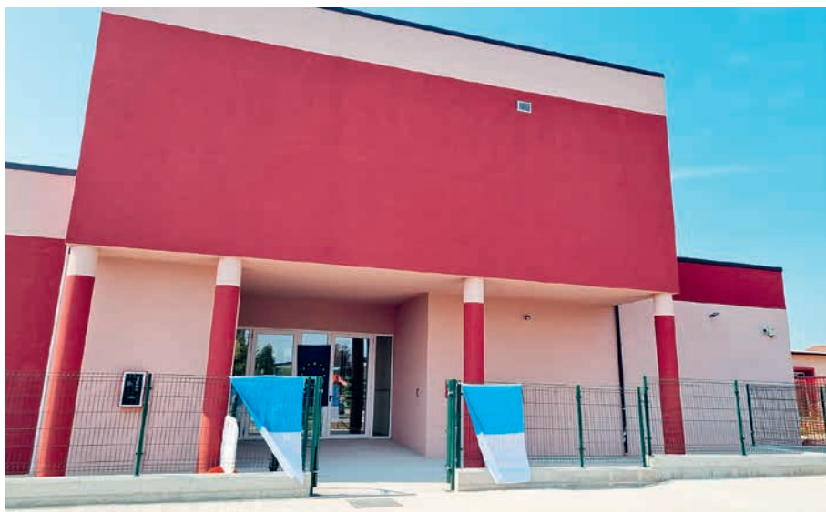
L'ingresso della nuova scuola primaria di San Pietro di Lavagno
