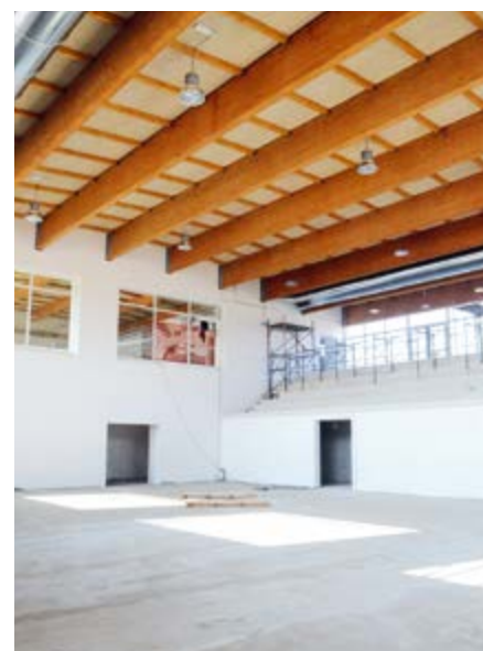
La palestra in fase di ultimazione
