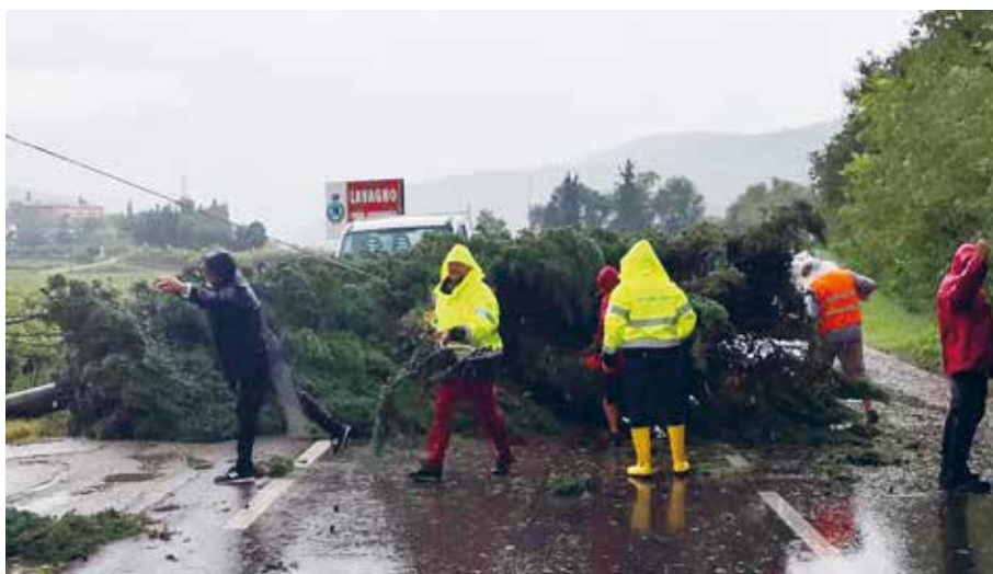
Al lavoro per ripristinare prima possibile la viabilità
